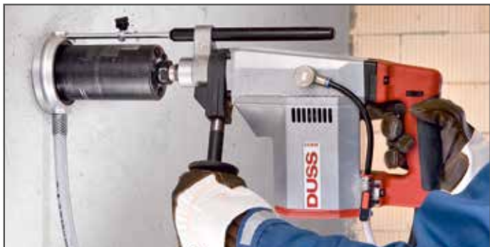
Noyage de boîtes à eau dans le béton avec aspiration d'eau
