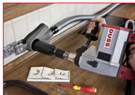
Forage à eau propre dans le béton avec cloche d'aspiration DUSS, à main
