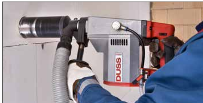
Noyage de boîtes à sec dans la brique silico-calcaire avec aspiration des poussières
