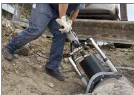
Forage de raccordement dans canalisation en béton, à eau et avec support BST
