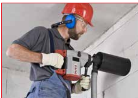
Forage dans la maçonnerie avec aspiration des poussières, à sec et à main
