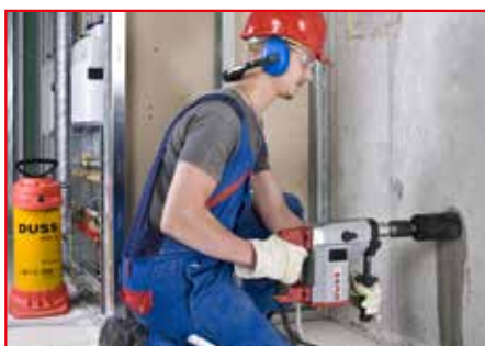
Noyage de boîtes dans le béton – à eau et à main
